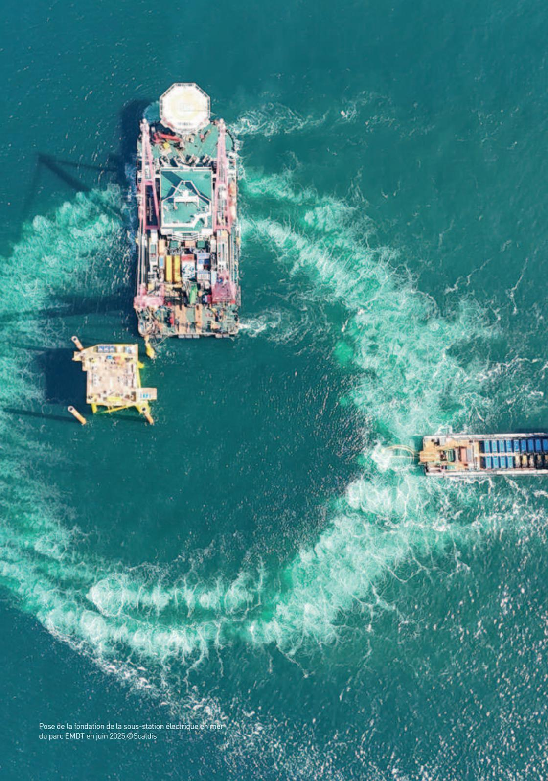
Pose de la fondation de la sous-station électrique en mer
