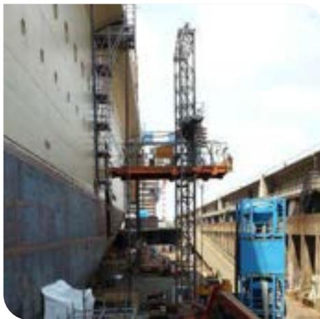
Elle est intervenue sur du support ingénierie méthode pour la mise en place d'un monte-charge en phase d'embarquement des équipements et armement de la sous-station des Chantiers de l'Atlantique.
